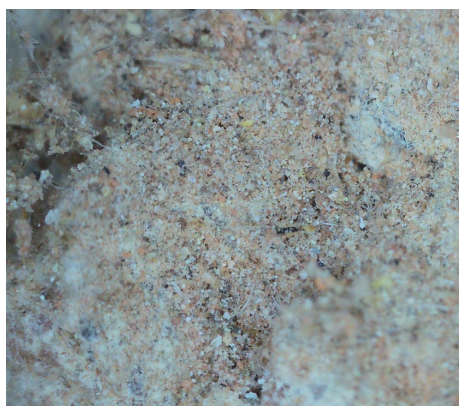
Mortero de cal entre adobes
