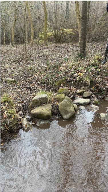
C1.4 COMPUERTA TIPO 4 Control de paso parcialmente regulable, de activación manual mediante la manipulación de cantos rodados sobre el surco de conducción.
