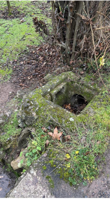
C2.1 CRUCE TIPO 1 Registro abierto y dispositivo de control de paso situado en el cruce de dos tramos de canalización ocultos, situados a diferente profundidad.
