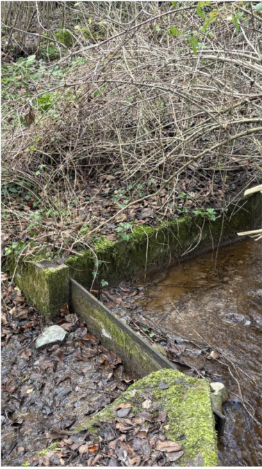
C2.4 CRUCE TIPO 4 Dispositivo de acometida y compuerta de paso situada en la bifurcación de un tramo de canalización exterior, para la regulación general del caudal.
