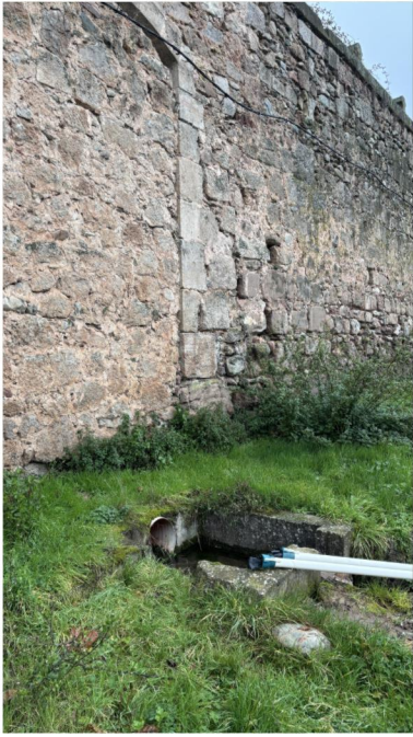
C2.3 CRUCE TIPO 3 Registro abierto y dispositivo de control de paso situado en la bifurcación entre varios tramos de canalización ocultos y/o visibles.
