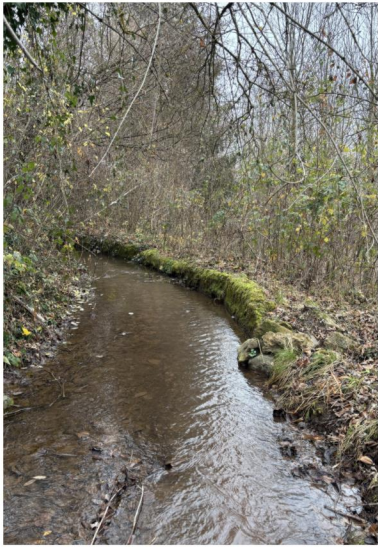
S1 Surco artificial externo para la canalización del agua, construido a partir de la manipulación del terreno para conformar los límites del cauce.
