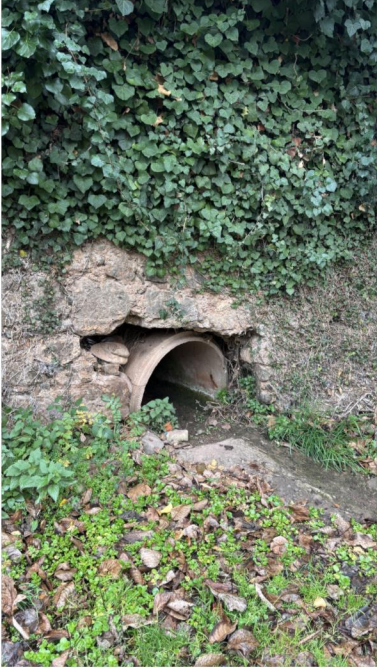
C3.4 CANALIZACIÓN TIPO 4 Canalización subterránea del caudal de riego mediante la introducción de tuberías cilíndricas, conformadas a partir de tramos prefabricados.
