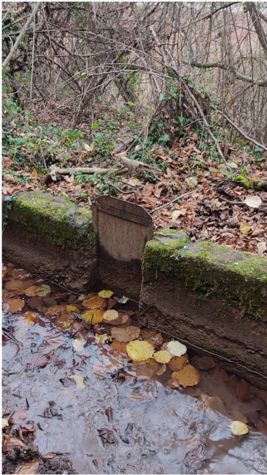
C1.3 COMPUERTA TIPO 3 Compuerta de paso no regulable, de activación mediante tracción manual, integrada en la delimitación de hormigón del canal.
