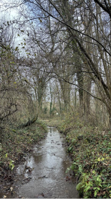
C3.1 CANALIZACIÓN TIPO 1 Surco artificial externo para la canalización del agua, construido a partir de la manipulación del terreno para conformar los límites del cauce.
