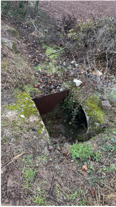
C2.2 CRUCE TIPO 2 Registro abierto y dispositivo de control de paso situado en el cruce entre un tramo de canalización oculto y un tramo de canalización híbrido.
