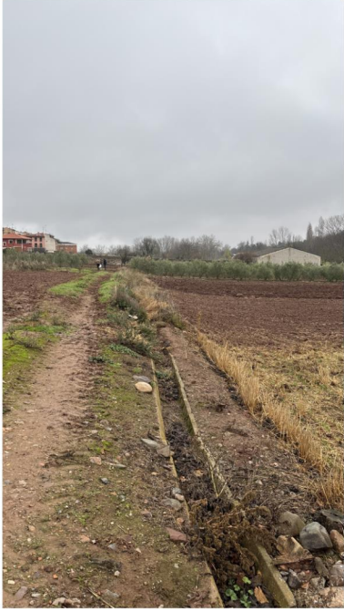
C3.3 CANALIZACIÓN TIPO 3 Construcción visible u oculta del cauce del agua mediante la disposición secuencial de una serie de piezas prefabricadas de hormigón.
