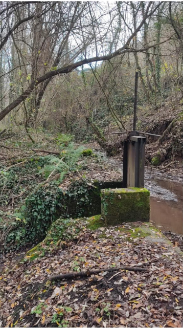
C1.1 COMPUERTA TIPO 1 Compuerta de paso regulable, de activación mecánica mediante sistema rotatorio manual, en estructura metálica sobre hormigón.
