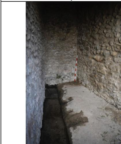
Fig. 3 - Fotografía general del interior del lavadero con losa desgastada por el uso
