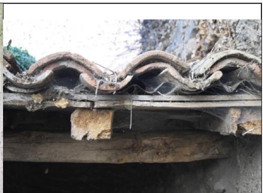
Fig. 2 - Fotografía de detalle de la cubierta con teja árabe
