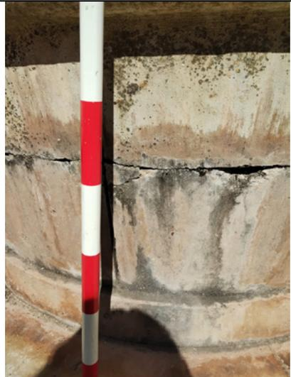
Fig. 3 - Detalle de los bloques de hormigón de la cisterna y la presencia de humedad en ellos
