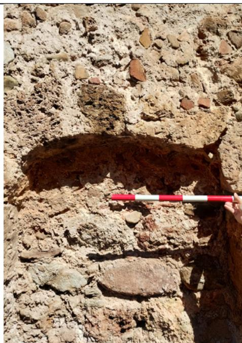
Fig. 7 - Detalle de la parte superior de la fuente formada por un arco rebajado sillares no canteados
