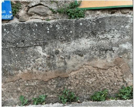
Fig. 6 - Fotografía donde se observa el muro revocado parcialmente de piedra y de hormigón
