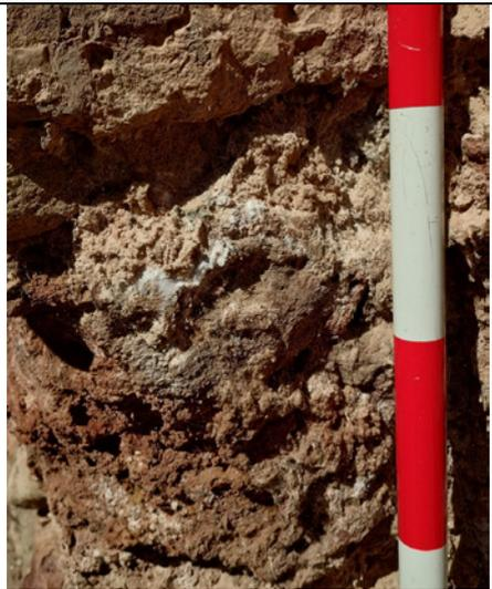
Fig. 3 - Detalle del lado izquierdo de la fuente con eflorescencias de carbonato de calcio
