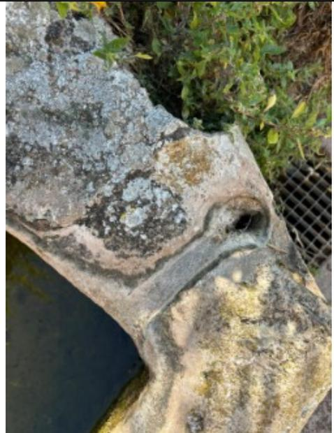
Fig. 4 - Fotografía de detalle de la esquina derecha donde se muestra el antiguo desagüe
