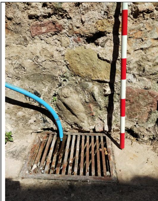
Fig. 6 - Detalle de la rejilla metálica que recoge el agua
